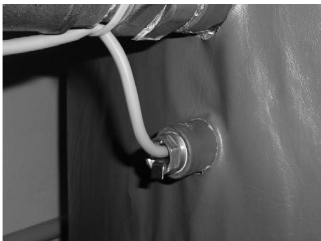
Fig. 13 – vandtemperaturføleren anbragt i en følerlomme i akkumuleringsstanken (TV og TS)
