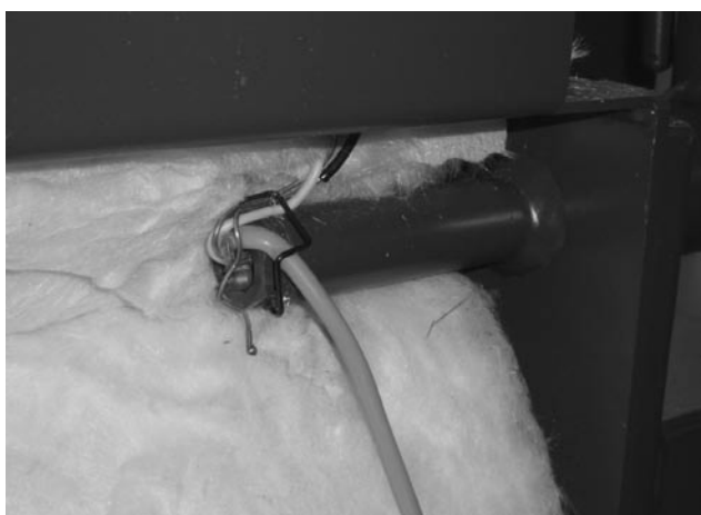
Fig. 15 - vandtemperaturføleren TK anbragt i en følerlomme i kedlen DCxxSP(EP) eller kedlerne DCxxS(X), CxxS, ACxxS, DCxxRS med fyret i den øverste låge
